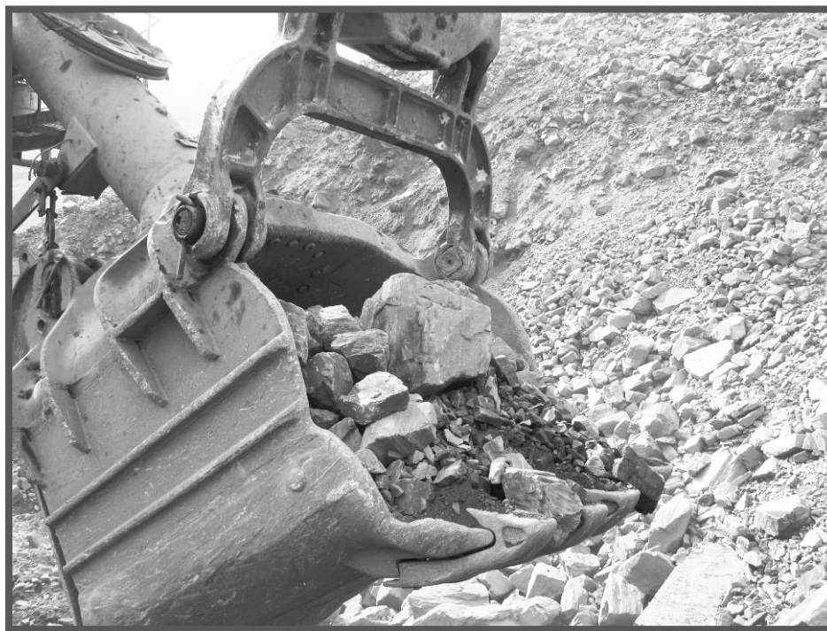
Рис. 1.6.1. Добычные работы на Михайловском ГОКе
