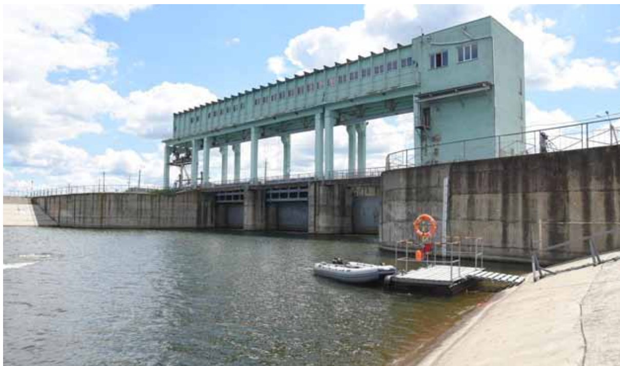
Рис. 15.6. Гидроузел Курского водохранилища
