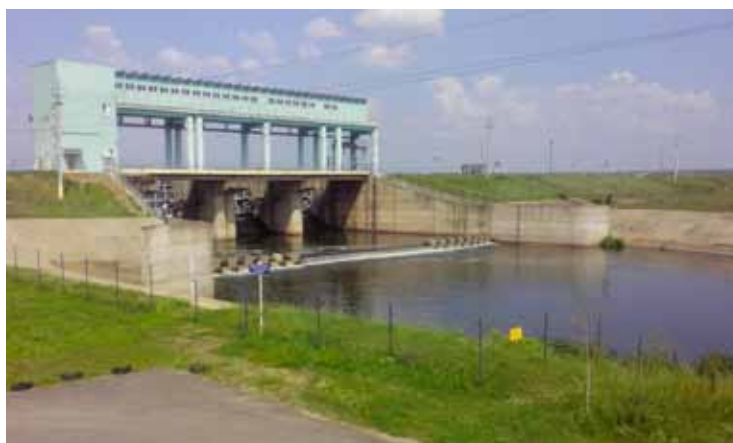
Рис. 5.3.1.1. Гидроузел Курского водохранилища на реке Тускарь
